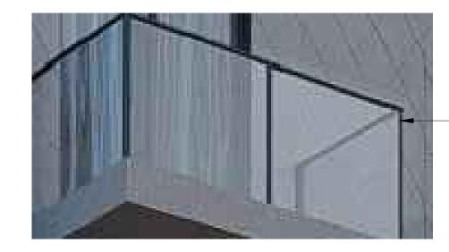
GARDE-CORPS VERRE TREMPÉ CLAIRE 4mm avec MAIN COURANTE PROFILÉ ARRONDI ALUMINIUM ANODISÉ NOIR ET **CONNECTIONS SOUDÉES**
